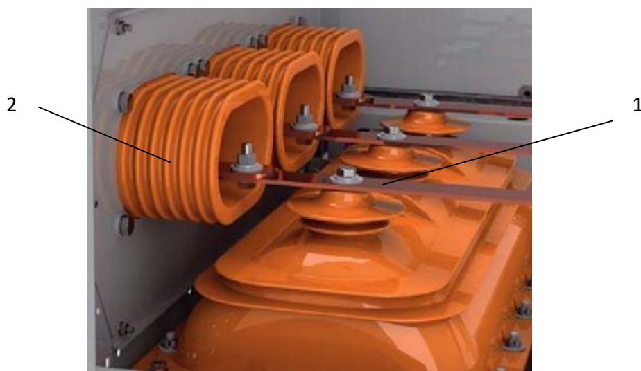
Рис. 15. Монтаж сборных шин:
